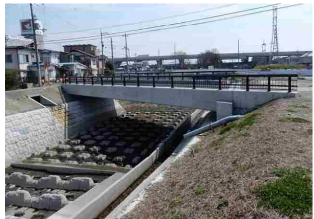
写真1 現在施工中の市道橋
