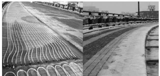
写真 2 写真 1 の改良 放熱管 50m 直線配管と縦断勾配で運転停止時は放熱管は残留水なし（橋面凍結なし）珪砂モルタルで良く溶けて打音検査でタイル剥がれもない木田橋、泉橋
