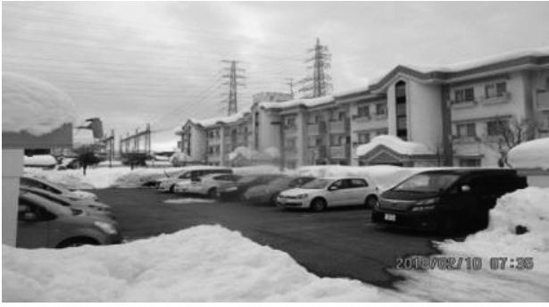
写真4 基礎杭貯水地中熱融雪 国内最初のエネルギーパイル 35年経過で循環ポンプだけは数年前に更新 舗装も放熱管も異常なし 県立大学職員住宅 福井市三郎丸
