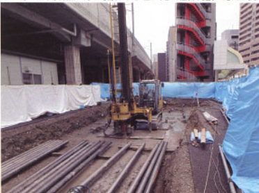
福井駅近郊の熱交換杭の打設現場。高架駅脇の歩道に、基礎杭と熱交換管の融雪システムを導入。日当たりが悪い、十分な蓄熱が得られないから、シミュレーションの結果、間隔を詰めた
