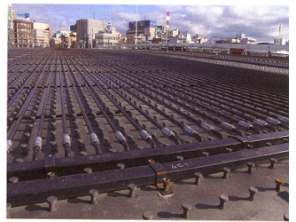
施工時の橋樑。放熱管が125mm間隔で平行に延びている。この後、鋼管杭補強コンクリートを10cmの厚さで打設した (写真：下も福井県雪対策・建設技術研究所)
