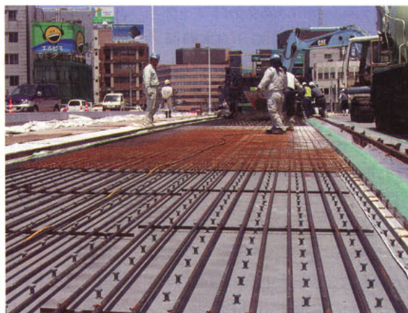
施工中の幸橋。縦に延びるのが放熱管で、2008年2月から運転を始めた。福井県は同様の融雪システムを駐車場などにも導入している
