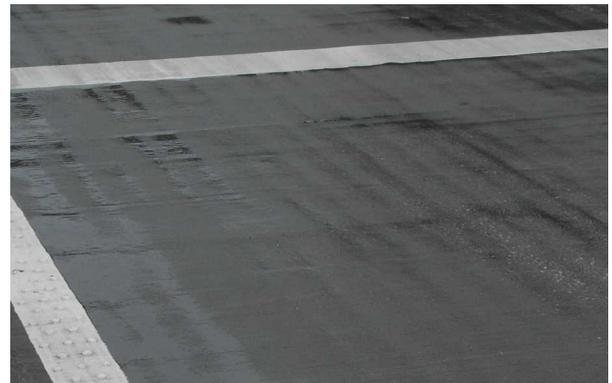
写真-3 放熱管上での凹みの発生
