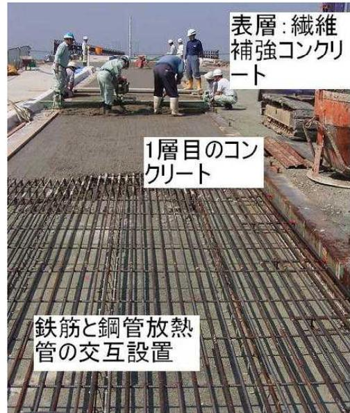
写真-1 乾燥収縮目地なしで35m曲げなし鋼管放熱管
