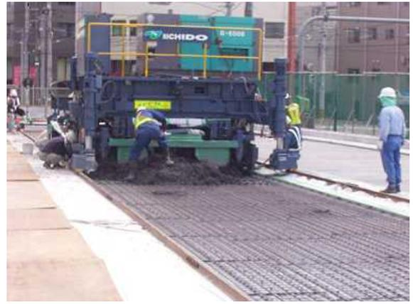
写真-2 鋼床版橋での放熱管とSFRCの施工
