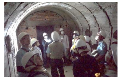
高知海軍航空隊の耐弾通信所跡（地下通所） （高知大学農学部・物部キャンパス 2025/08/30）
